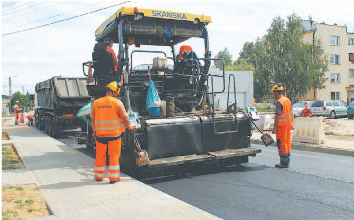
Rozpoczęły się prace na ostatnim odcinku ulicy ul. Matejki, w związku z tym wjazd na tę ulicę od ul. 1 Maja będzie zamknięty
