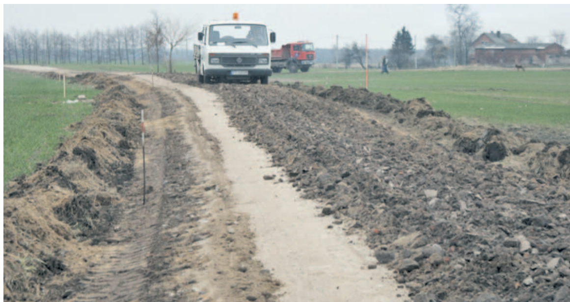
Prace przy przebudowie drogi gminnej Kurkocin – Wielkie Pułkowo
