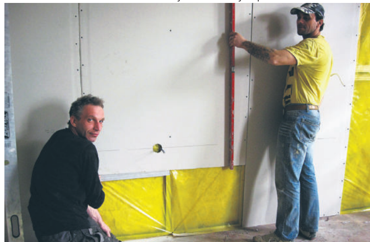
Rozpoczął się remont kapitalny na Oddziale Chirurgii Ogólnej
