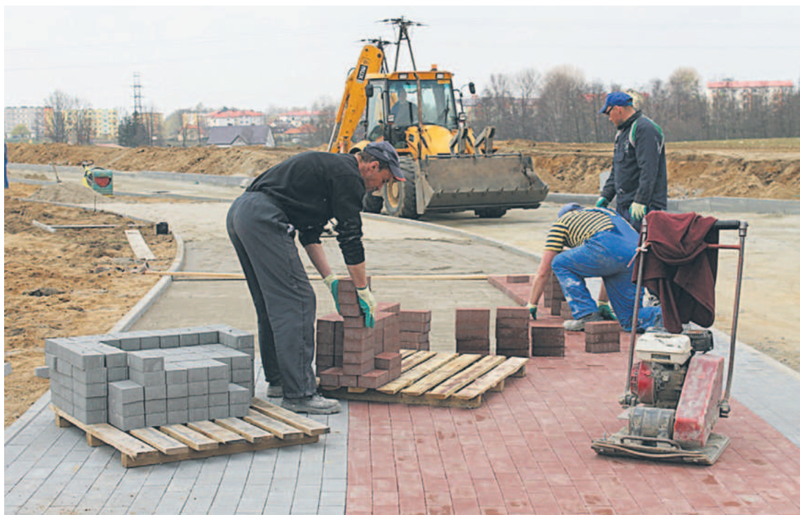
Bezrobotni zatrudnieni w MZUK będą sprzątać tereny miejskie, pomagać w utrzymaniu zieleni, pracować przy remontach dróg i chodników oraz w betoniarni
