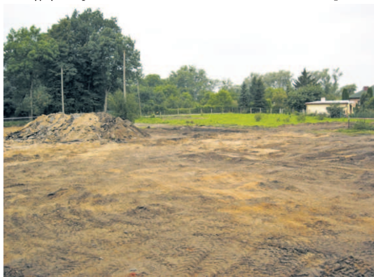
Ruszyła budowa boiska przy SP2
