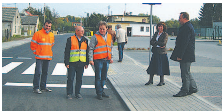
W poniedziałek przeprowadzono odbiór techniczny ulicy Matejki
