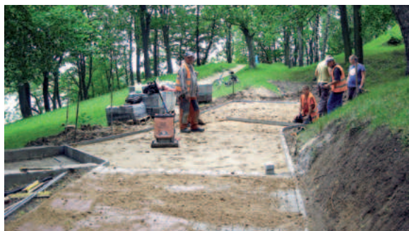
Rozpoczęła się budowa ścieżek rowerowych na Górze Zamkowej
