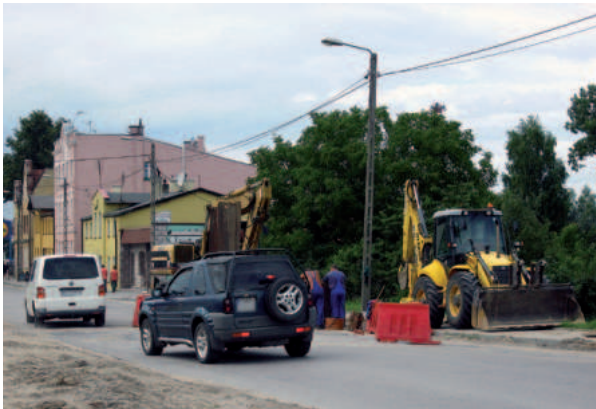
Na ul. 1 Maja wkrótce zakończą się prace przy budowie kanalizacji deszczowej
