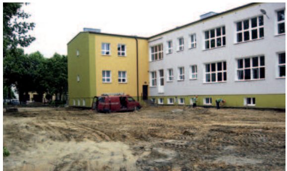
Przy Szkole Podstawowej nr 3 rozpoczęła się budowa placu manewrowego. Będzie tam kilkadziesiąt miejsc postojowych dla samochodów
