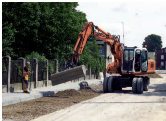
Powoli dobiega końca remont ul. Partyzanta. Asfalt położony będzie za kilka dni
