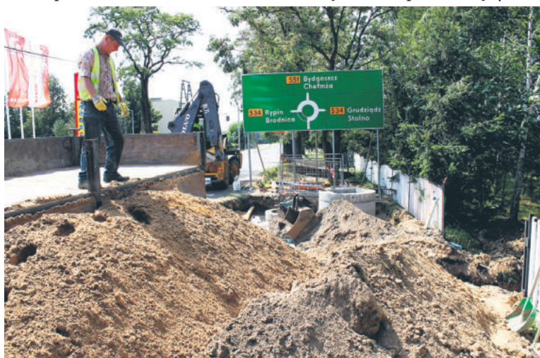
Budowa kanalizacji sanitarnej na ulicy Mikołaja z Ryńsk
