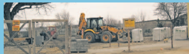
W Myśliwcu rozpoczęła się budowa hali
