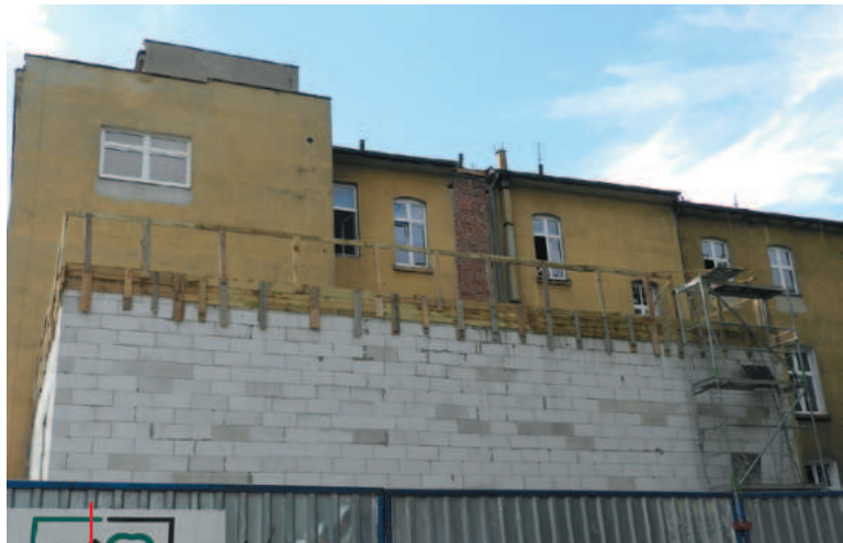
Prace na budowie wznowiono na początku sierpnia
