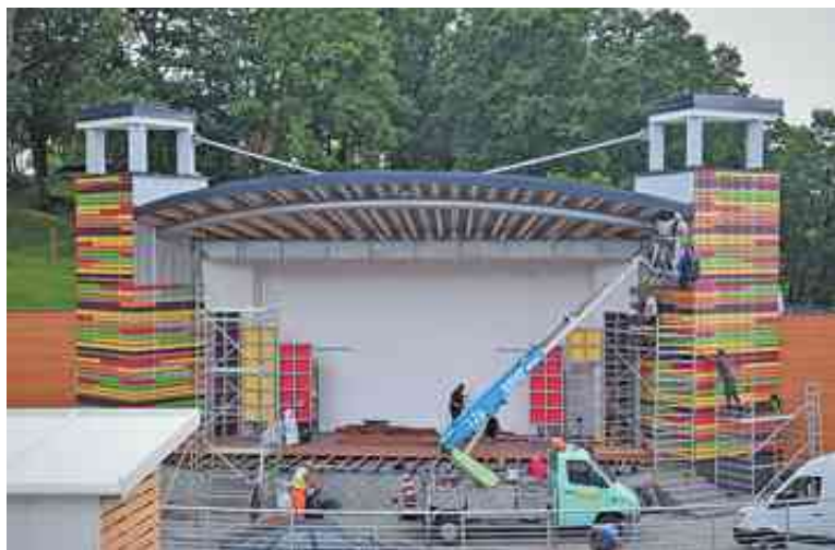
Trwają prace przy przebudowie amfiteatru
