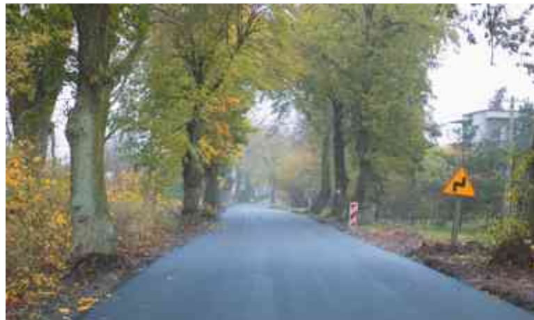
Droga Bursztynowo – Blizno po modernizacji
