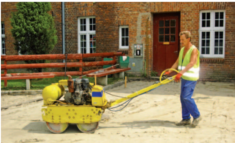
Prace przy SP 2
