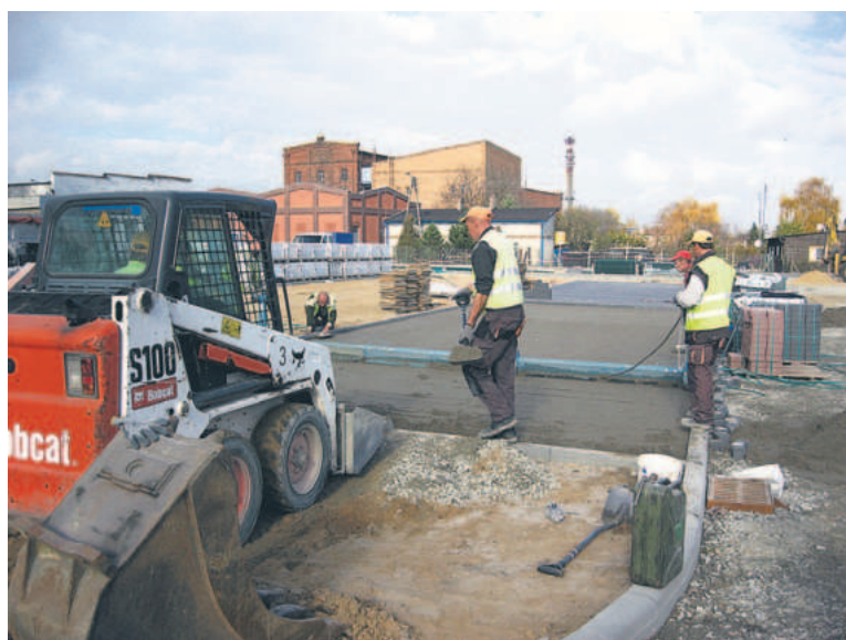
Robotnicy mają jeszcze do wykonania m.in. ciągi komunikacyjne
