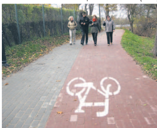
W poniedziałek pracownicy Wydziału Gospodarki Komunalnej i Mieszkaniowej wraz z komendantem straży miejskiej Krzysztofem Grzybkiem dokonali przeglądu oznakowania poziomego i pionowego ścieżek
