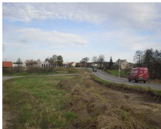
Roboty budowlane w miejscowości Małe Pułkowo
