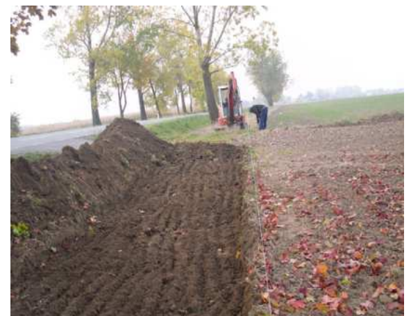
Roboty budowlane w miejscowości Wielkie Radowiska
