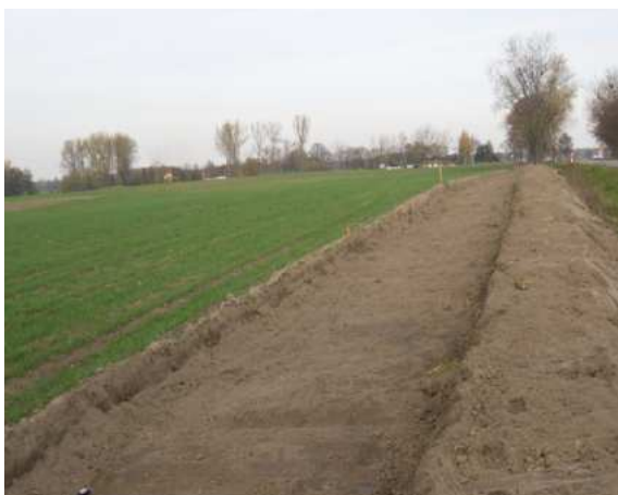
Roboty budowlane w miejscowości Wielkie Radowiska
