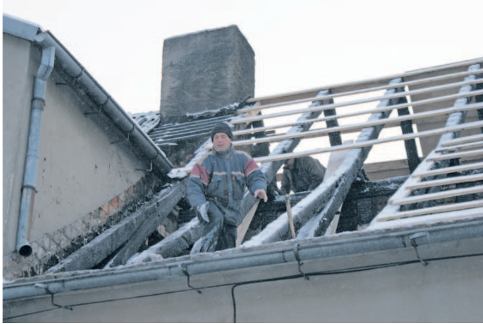
Remont spalonej części dachu
