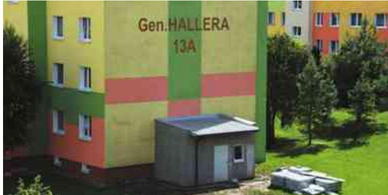
Spółdzielcze bloki będą miały własne kotłownie gazowe
