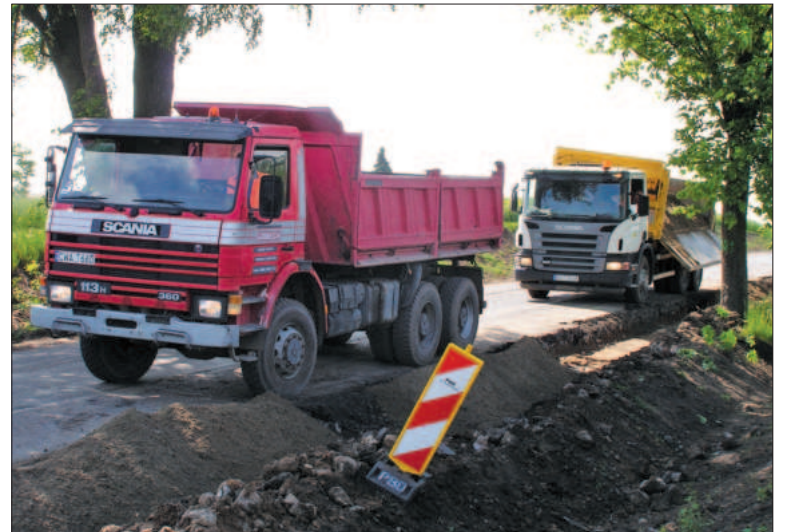
Drogowcy pracują w wielu punktach na niemal 50-kilometrowej trasie „534”. Kierowcom pozostaje stanie w korkach lub szukanie objazdów
