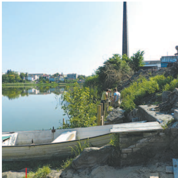
Prace trwają, bo czas nagli
