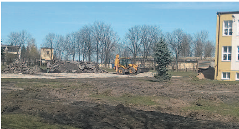
31 marca ruszyły prace przy budowie boisk
