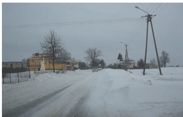
Hałdy śniegu na poboczach to problem, który dotyczy wszystkich dróg (na zdj. do Kowalewa Pomorskiego)
