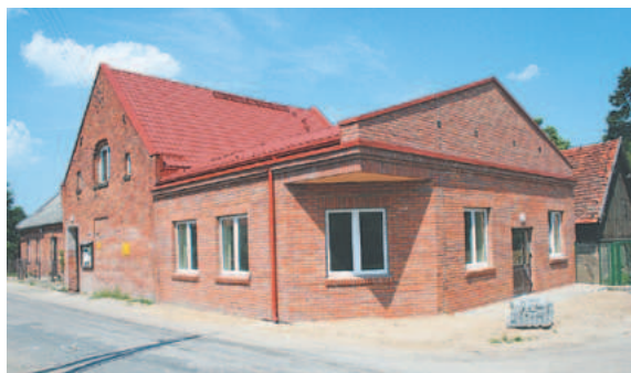
Mieszkańcy Stanisławek doczekali się większej świetlicy. Dobudowywana do niej została sala o powierzchni 90 m kw. Oprócz tego na istniejącym wcześniej budynku wymieniono dach
