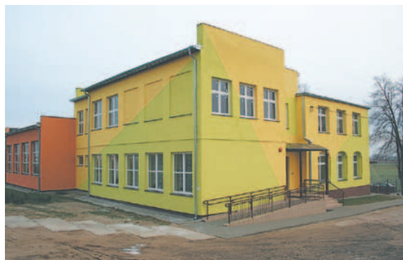
W Szkole Podstawowej w Jarantowicach wykończono nadbudowane w ubiegłym roku piętro, dzięki któremu w szkole przybyło pięć sal lekcyjnych
