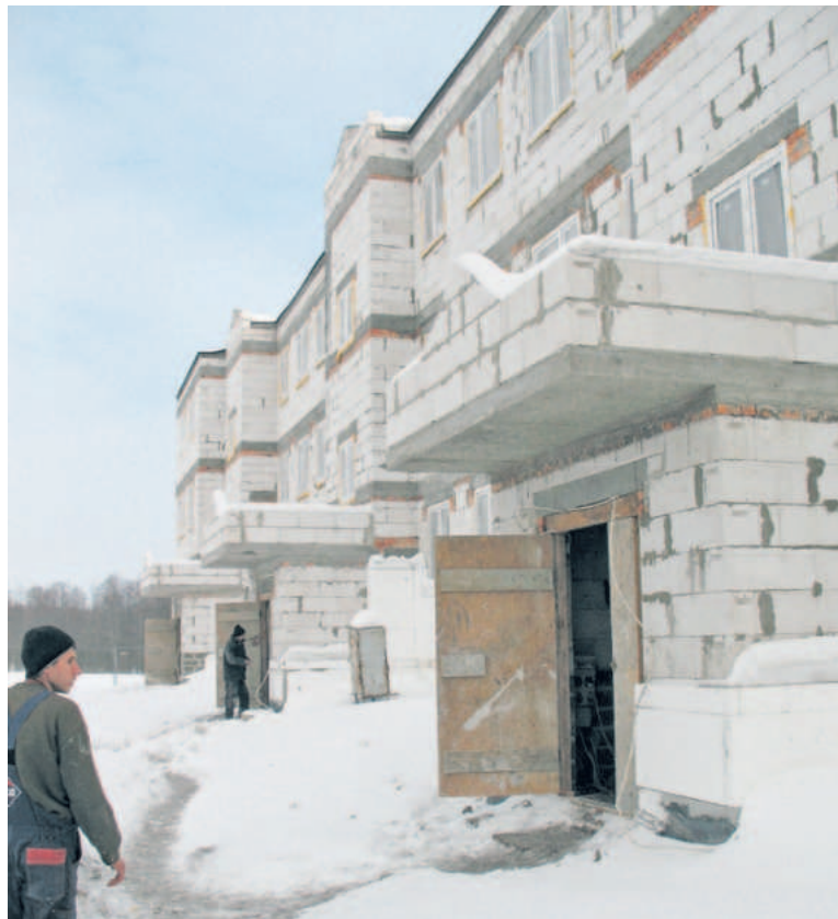
Po zimowej przerwie rozpoczynają się prace na zewnątrz budynku
