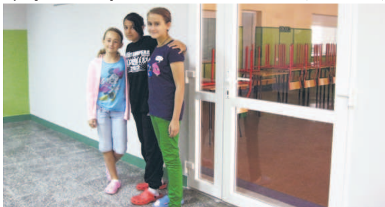
Gimnazjum: W świetlicy postawiono nową ścianę, wstawiono nowe drzwi, zbędne drzwi zamurowano, ściany wyłożono gładzią i pomalowano
