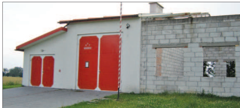
Remiza strażacka w Niedźwiedziu wraz z wzniesionymi ścianami zewnętrznymi świetlicy wiejskiej
