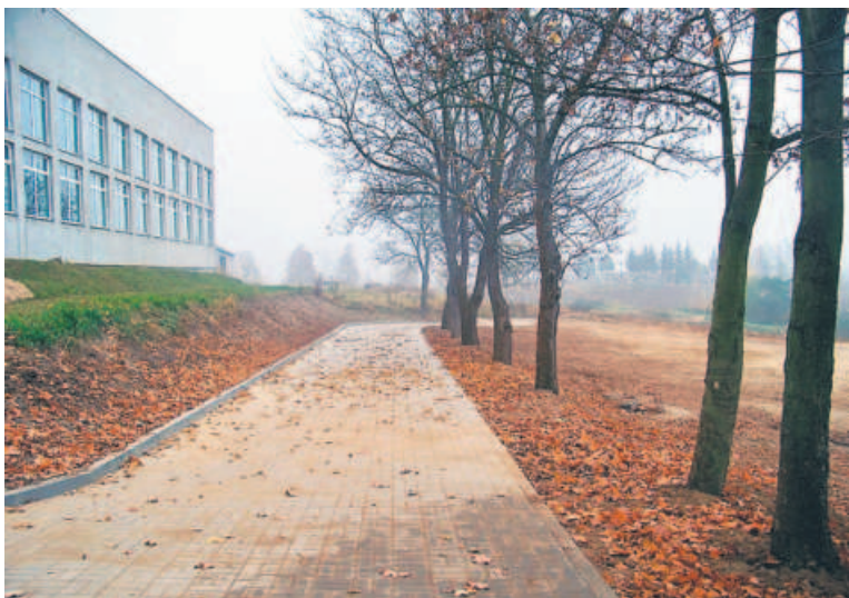
Pierwszy etap prac budowy kompleksu sportowego przeprowadzono w ubiegłym roku
