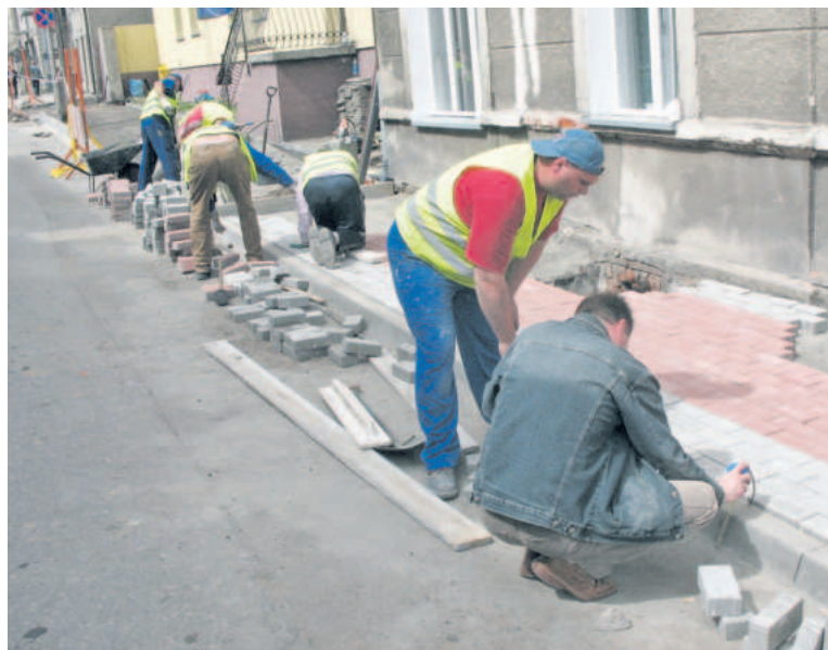
Większość prac przy układaniu chodników wykonują pracownicy MZUK
