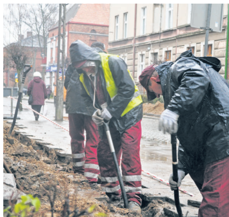
Są szanse na to, że prace ziemne przy ul. Wolności zakończą się jeszcze w tym miesiącu
