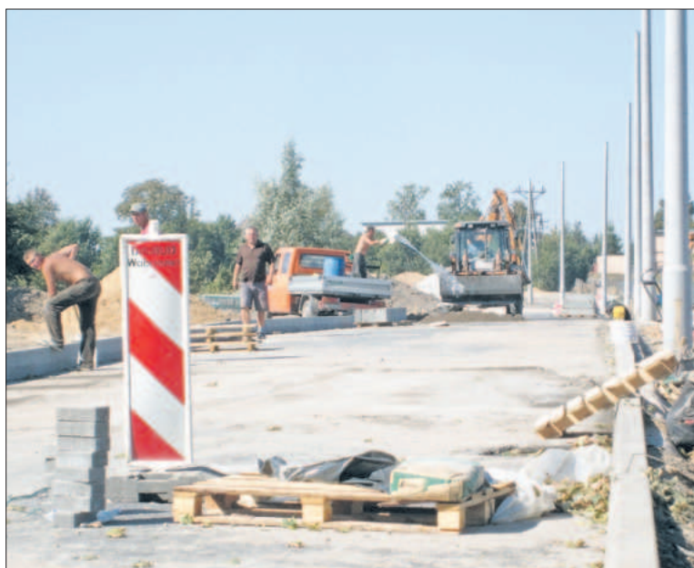
Prace trwają – modernizacja ma być ukończona do 30 listopada
