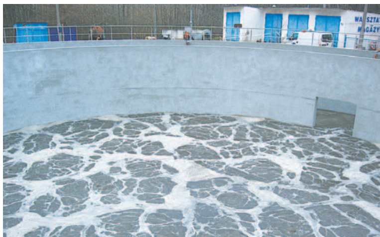
W ubiegłym tygodniu przeprowadzono rozruch reaktora – został napełniony ściekami i włączony w ciąg technologiczny oczyszczalni
