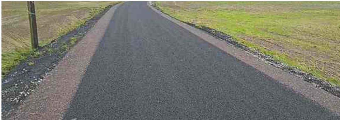
Nowa nawierzchnia na drodze Bielawy – Ostrowo
