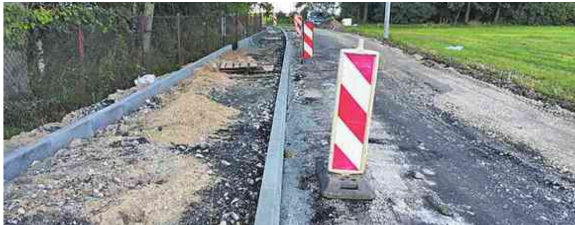
Trwa przebudowa drogi w Wielkądzu
