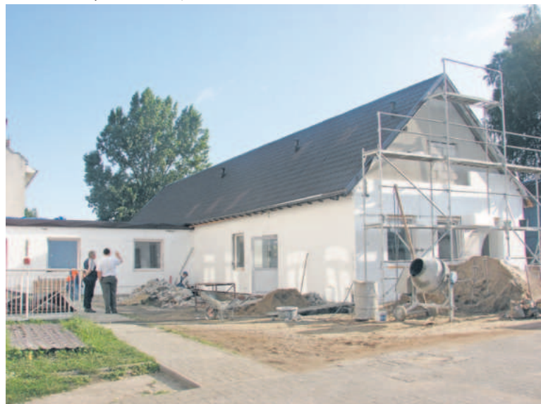
Remont szkoły, tzw. kurnika
