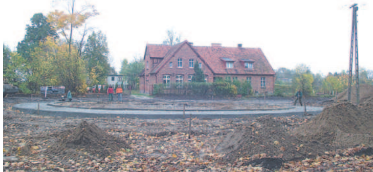
Prace obejmują budowę ronda na skrzyżowaniu z drogą na Jaworze, położenie asfaltu na jezdni o szerokości 7 m, rozbudowę chodników, wykonanie wysepek zwalniających i zatoczek autobusowych oraz odwodnienie i oświetlenie
