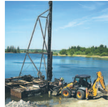
Prace nad Jeziorem Zamkowym już się rozpoczęły
