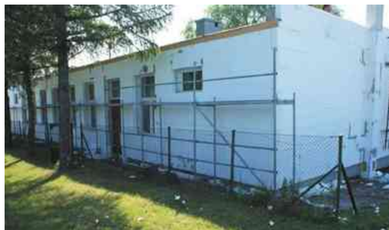
Prace termomodernizacyjne budynku świetlicy wiejskiej w Wielkim Pułkowie
