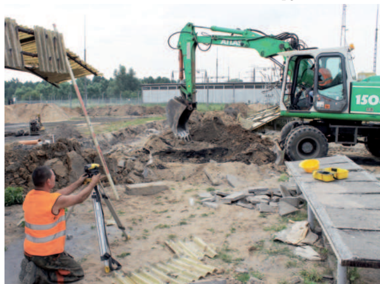
Obecnie na wąbrzeskim targowisku trwa budowa kanalizacji deszczowej
