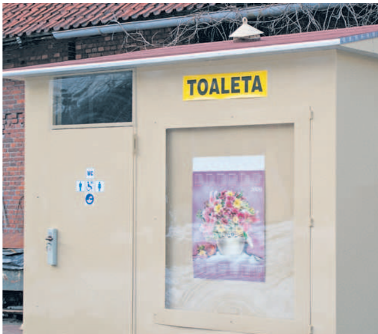
Budynek nowego szaletu już czeka na ustawienie go przy ul. Poniatowskiego
