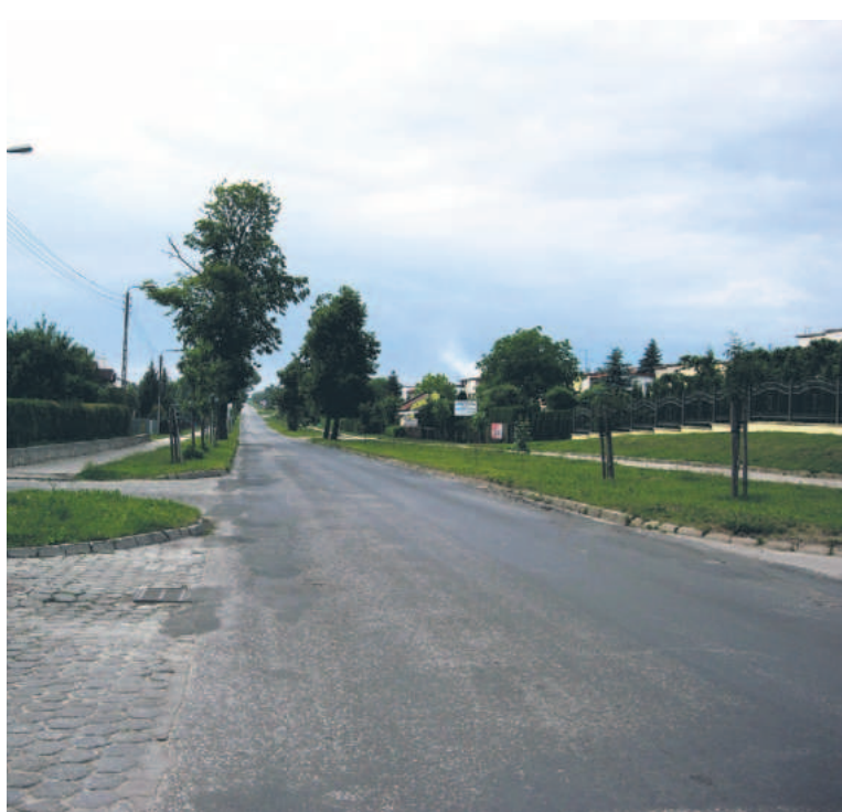
Pierwsze roboty będą prowadzone na ul. Grudziądzkiej (na odcinku od ul. Bocianie do Żurawiej). Widok od ul. Bocianie
