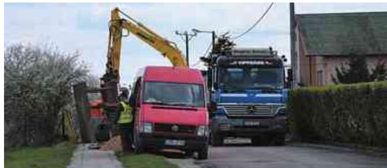
Przebudowa ul. 750-lecia Wąbrzeźna. Przed drogowcami MZECWiK realizuje swoją inwestycję
