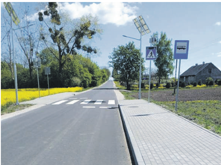
Tak wygląda zmodernizowana droga w Goryniu
