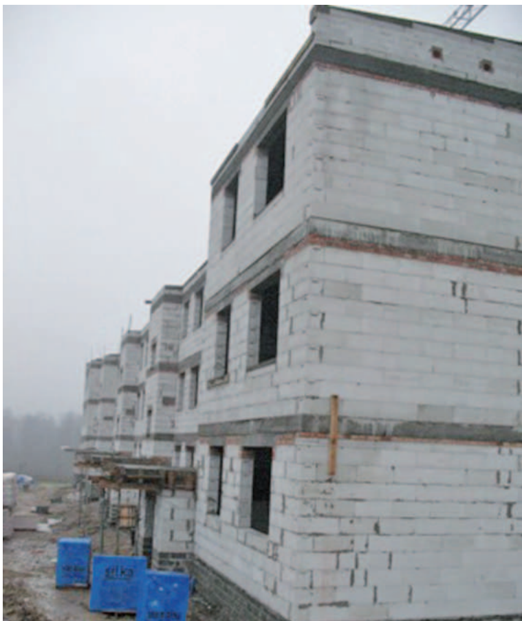
Wewnątrz powstającego budynku socjalnego zimą będą prowadzone prace wykończeniowe
