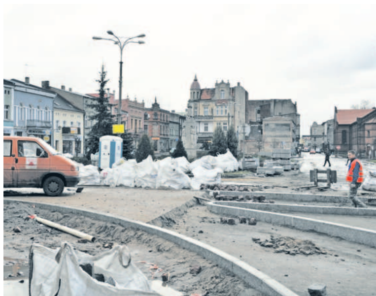
Spośród prac prowadzonych w tym roku najbardziej rzucają się w oczy roboty na Placu Jana Pawła II
