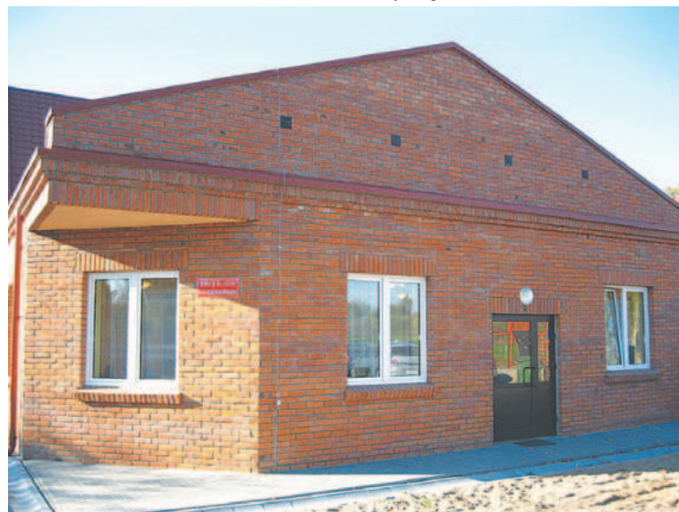
Nowa świetlica została dobudowana do budynku kaplicy
