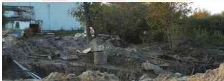
Budowa przepustu pod ul. Kętrzyńskiego to jeden z etapów modernizacji drogi wojewódzkiej
