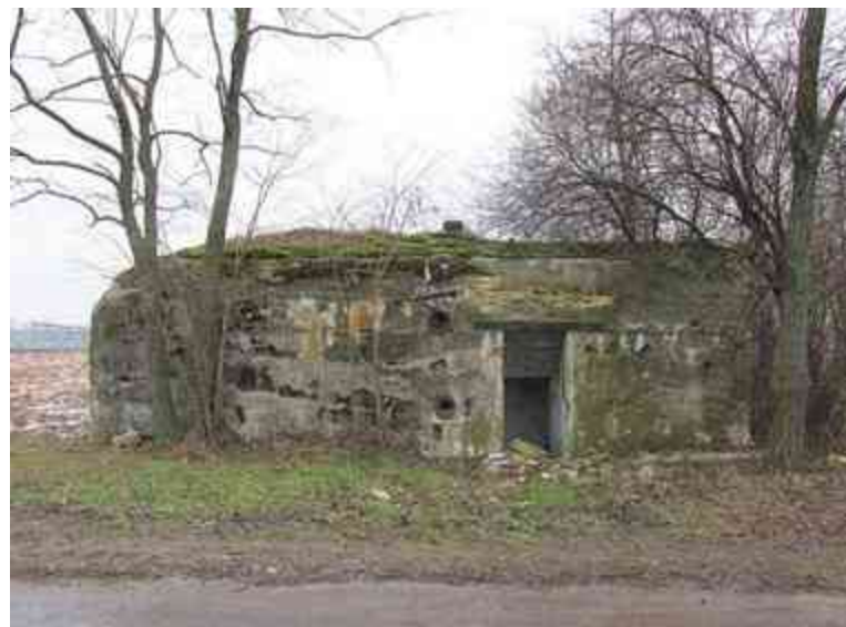
Wykopany schron „Tobruk” w Nowym Dworze
