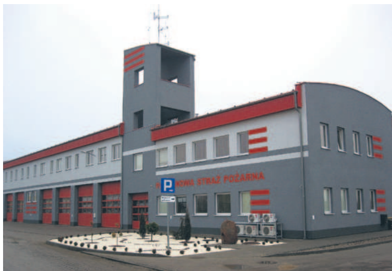
Po 8 latach od rozpoczęcia budowy nowa remiza jest gotowa
