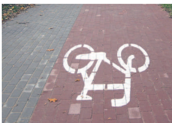
W listopadzie zakończyła się budowa ścieżki rowerowej w miejscowościach Małe Pułkowo i Wielkie Radowiska
