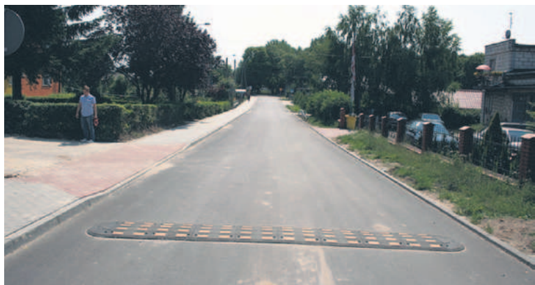
W maju rozpoczęła się przebudowa drogi gminnej Wałycz-Mysliwiec
