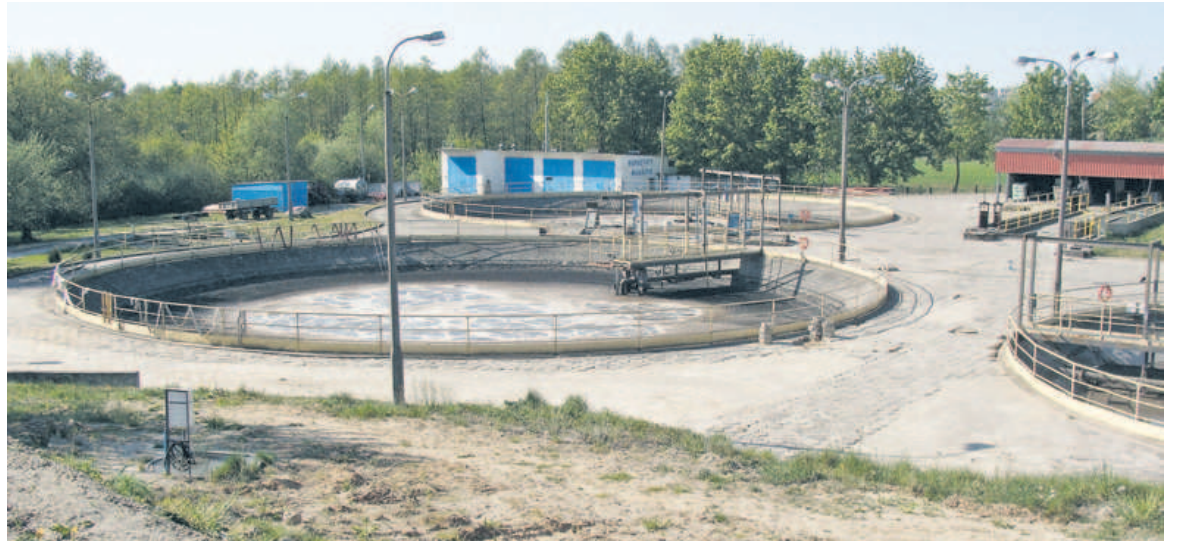
Oczyszczalnia ścieków jest modernizacją od pięciu lat
