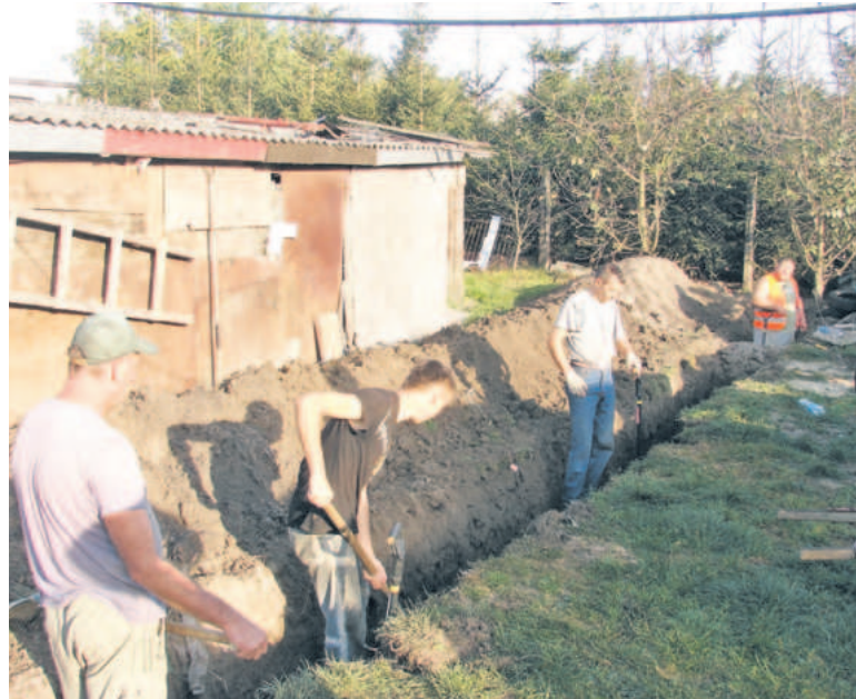
Wodociąg często przechodził przez prywatne podwórka i praca przy nim wymagała pracy ręcznej
