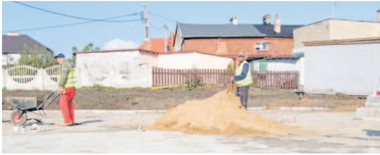
Nawierzchnia parkingu jest już niemal gotowa, pozostały tylko prace wykończeniowe
