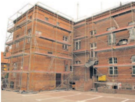
W pierwszej kolejności naprawiane są ściany ceglane budynków urzędu od strony podwórza
