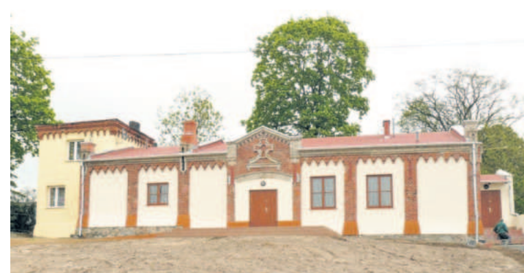
Nowo wyremontowana świetlica w Kikole
