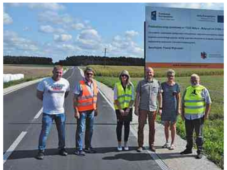
Odbioru przebudowanej drogi dokonali przedstawiciele inwestora, wykonawcy oraz nadzoru inwestorskiego
