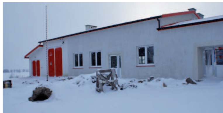
Wykonano już konstrukcję dachu wraz z pokryciem, wstawiono okna i drzwi
