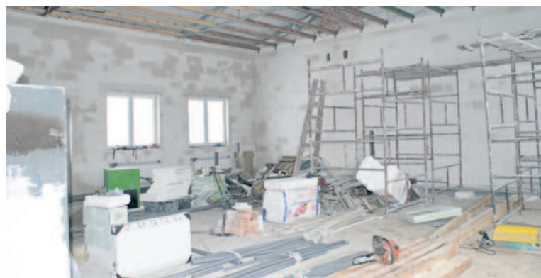
Wewnątrz wykonano instalacje: elektryczną, wodno-kanalizacyjną i w najbliższych dniach nastąpi podłączenie centralnego ogrzewania, co ułatwi dalsze wykonywanie prac wewnętrznych
