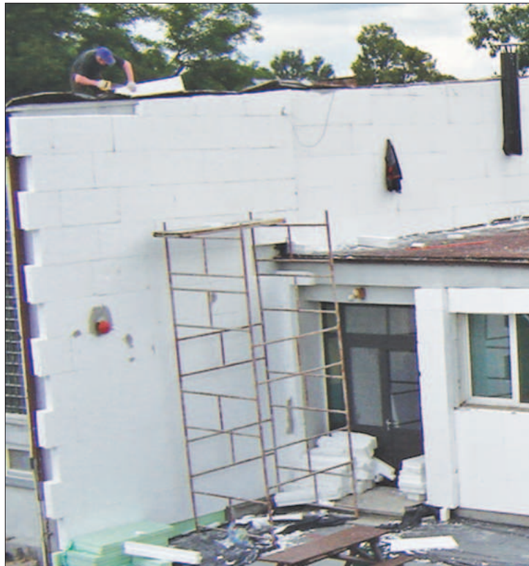
Termomodernizacja budynku Zespołu Szkół w Dębowej Łące
