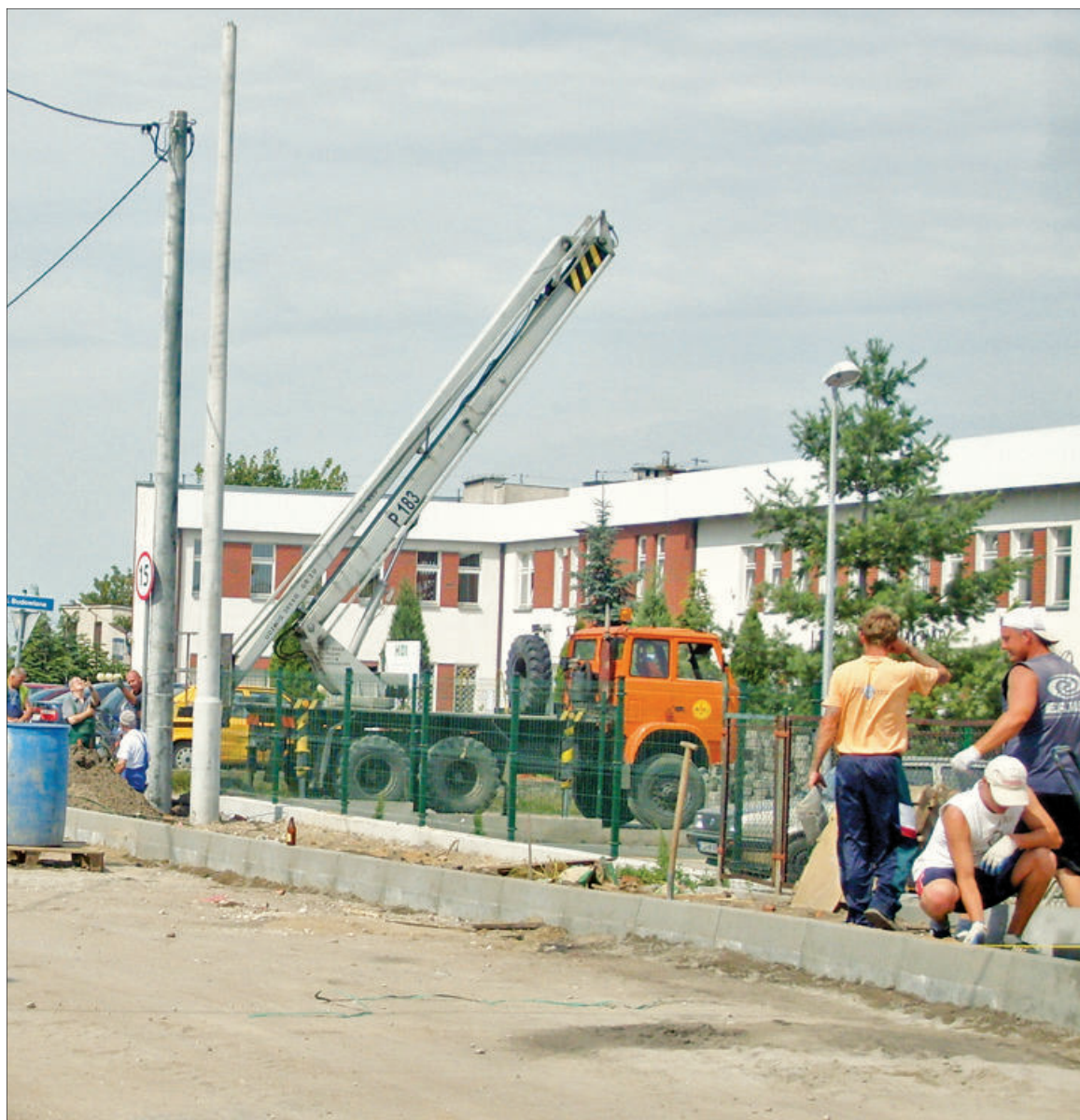
Prace trwają niemal na całej długości ul. Rataja
