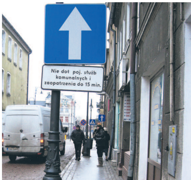
Od podłoża do krawędzi znaku jest 1,84 m, a powinno być 2,20 m
