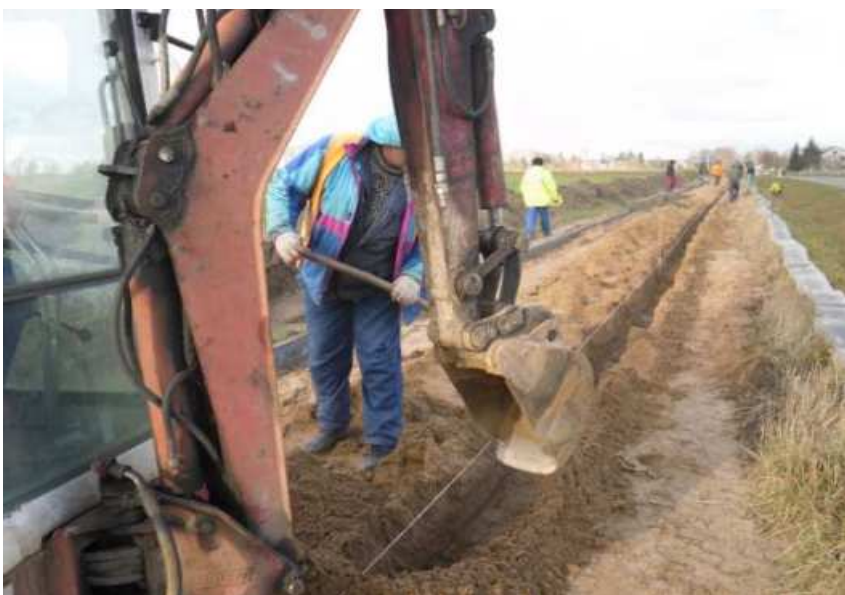
W trakcie budowy ścieżka rowerowa w miejscowości Małe Pułkowo
