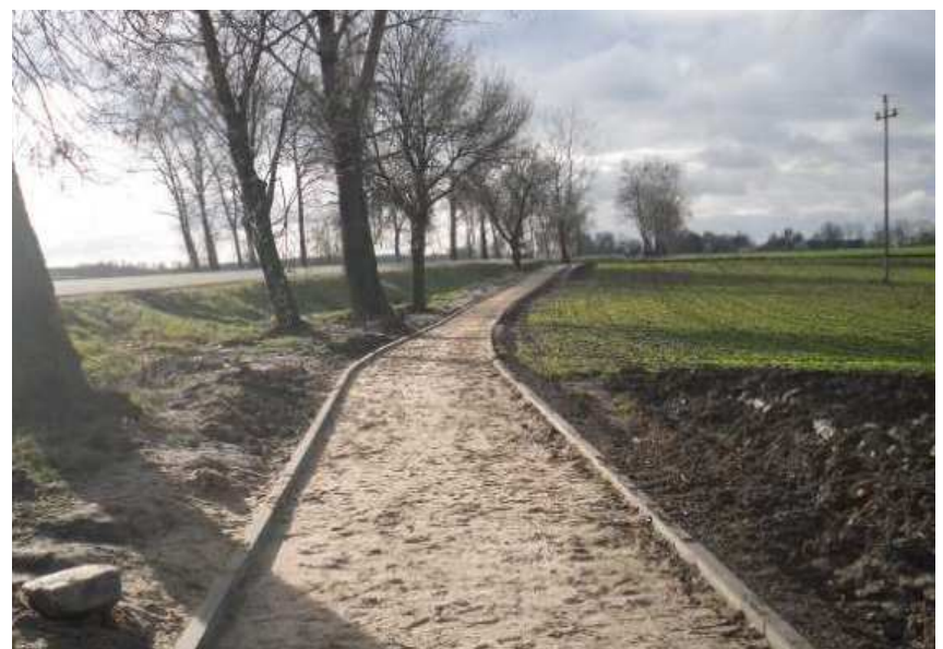
W trakcie budowy ścieżka rowerowa w miejscowości Wielkie Radowiska
