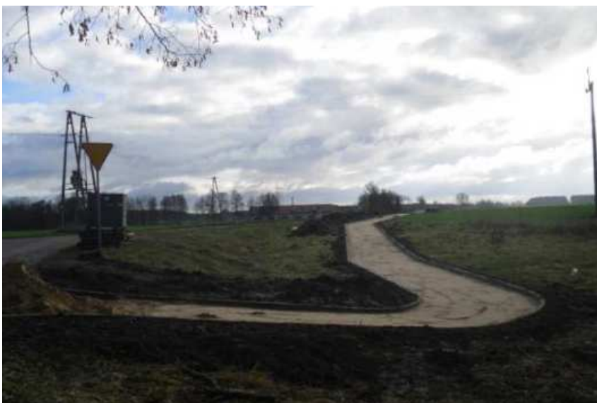
W trakcie budowy ścieżka rowerowa w miejscowości Wielkie Radowiska
